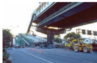
倒壊した阪神高速道路
