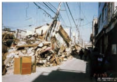
住家被害と延焼被害の様子 (阪神・淡路大震災)
