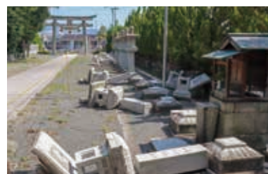
震災で倒れた灯篭
