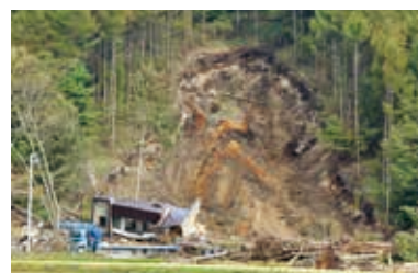
土砂崩れにより崩壊した民家
