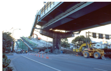
倒塌的阪神高速公路
