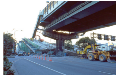
붕괴된 한신 고속 도로
