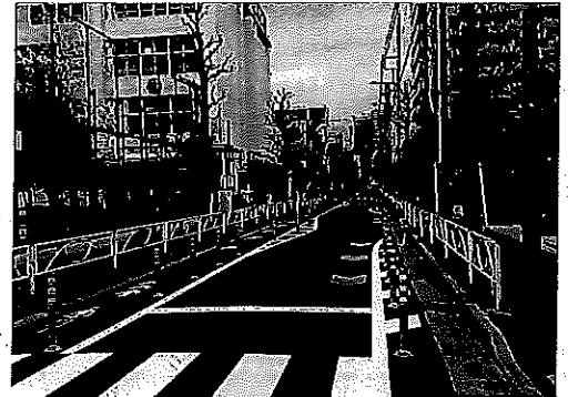
写真：外手小学校前に設置された車のスピードを抑えるポール
