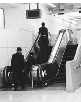
設置された両国駅のエスカレーター
