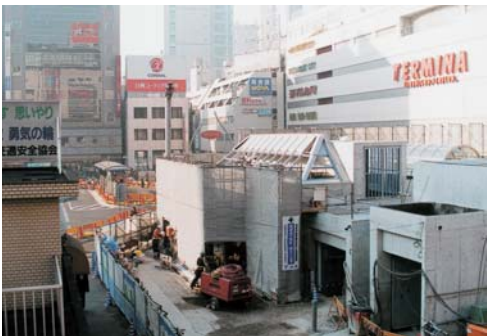
整備が進む錦糸町駅南口
