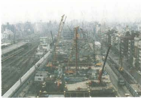
錦糸町駅北口再開発地区
