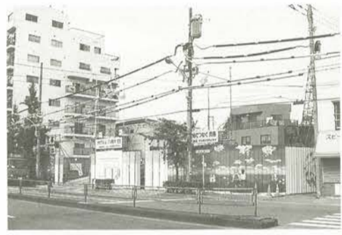
第二特別養護老人ホーム建設現場
