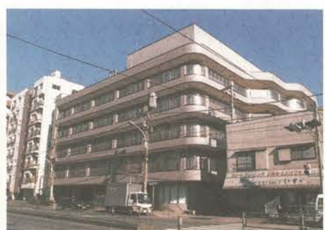
建設中のたちばなホーム
