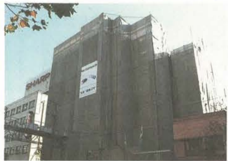
建設中のシテイハイム石原
