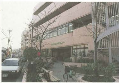
在宅介護支援センターが併設されている福祉保健センター
