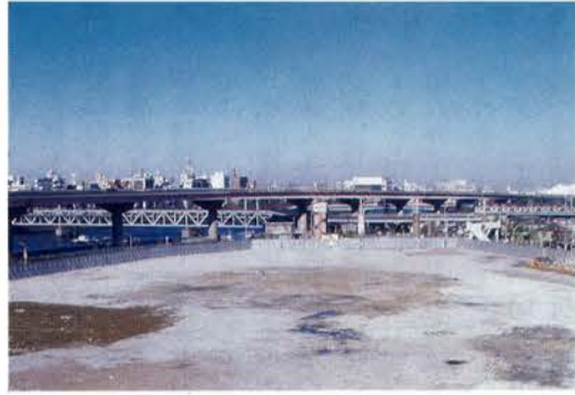
総合庁舎・タウンホール建設用地
