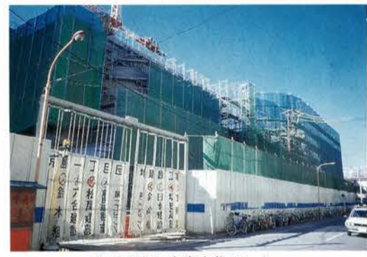
建設が進む曳舟文化センター
