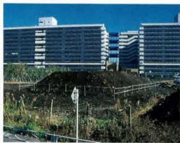
白鬚東地区残工事現場
