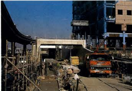
区道付け替え工事(吾妻橋付近)
