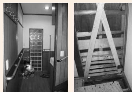
バリアフリー改修の一例 耐震改修の一例
