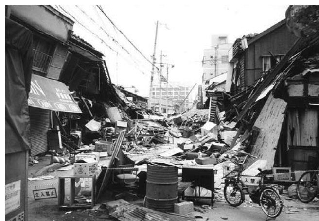
阪神・淡路大震災により倒壊し、道路をふさぐ木造住宅 (写真提供)阪神・淡路大震災まち支援グループ まちコミュニケーションより
