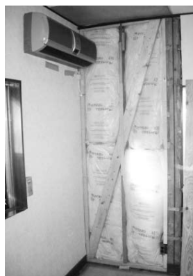
耐震改修の一例
