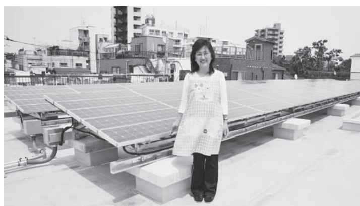
花園保育園の屋上には、太陽光パネル(縦33cm、横130cm)を約200枚設置しています。晴れた日は30kwh以上発電することもあり、園内の照明やコンセントなどの電力に使用しています。
