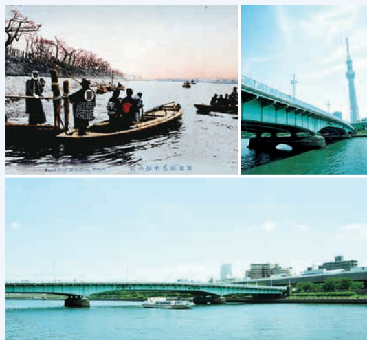
【左上】明治時代の「竹屋の渡し」 【右上】隅田川西側から見た言問橋と東京スカイツリー® 【下】橋の上部にアーチがないのが特徴で、見通しが良い言問橋
