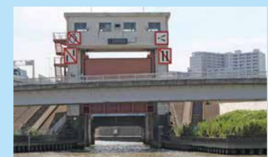
船から見た隅田水門
