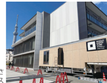
▶大学の敷地内に設置されたトレーラーハウス
