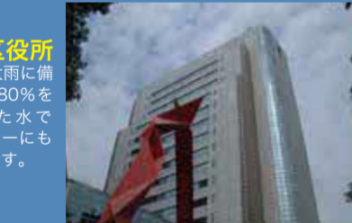
墨田区役所 地下1,000tのタンクのうち500t分は大雨に備えて使えます。2・3階のベランダのコンテナボックスで雨水を浄化した水でまかっています。別棟の壁面緑化コーナーにも小規模な雨水利用システムを導入しています。1990年竣工。
