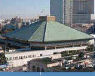
国国技館 8,400㎡の大屋根に降った雨水を1000tの地下のタンクにためて都市型洪水を防ぎます。ためた雨水は、17万人を超える観客のトイレ洗浄水及び防炎用水として活用します。日本の大規模な雨水利用施設の第1号です。1985年竣工。
