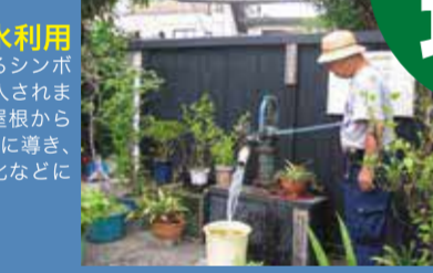
商業ビル雨水利用 道頓堀になる路地を大切にしたい。また、地下のタンクに水をため、3tから10tの地下のタンクに導き、手押しポンプで水をくみ出して普段は緑化などに利用します。
