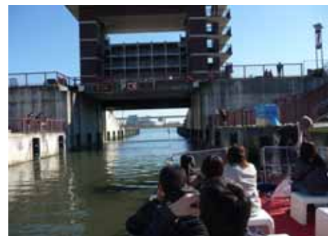
荒川ロックゲート（旧中川 荒川）
