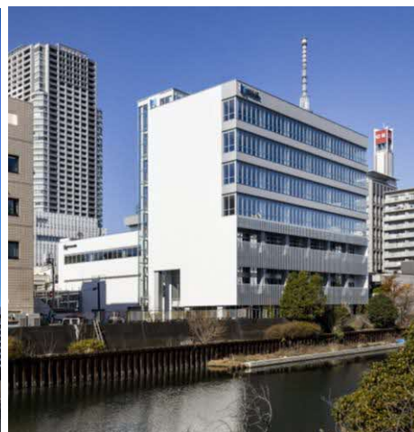
横十間川からの外観
