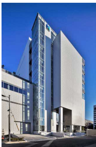
前面道路からの外観
