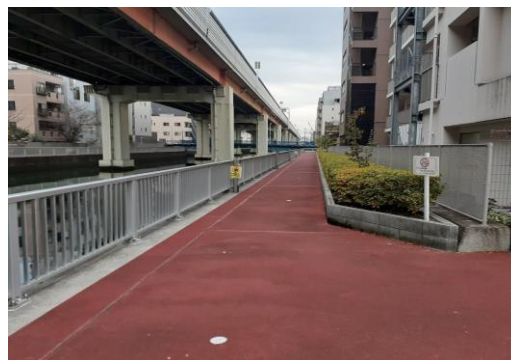
写真 豎川テラス
