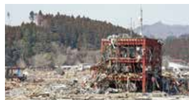
震災直後の防災対策庁舎
