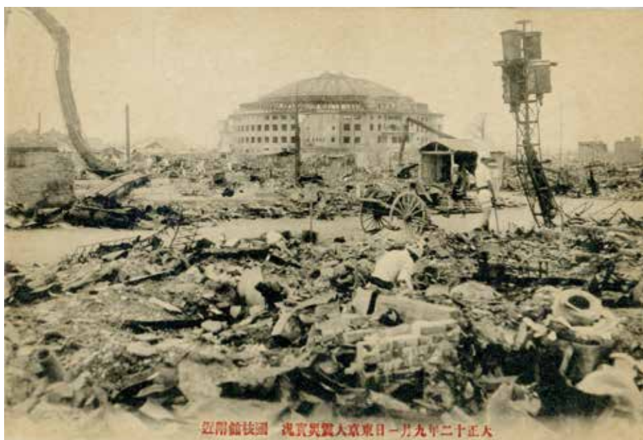
旧国技館の焼け跡
