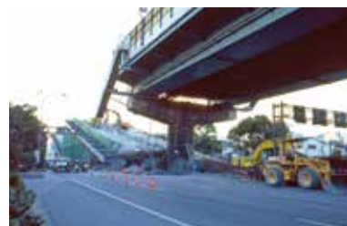
倒壊した阪神高速道路
