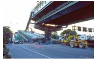
붕괴된 한신 고속 도로
