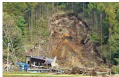
因土砂塌方毁坏的民家
