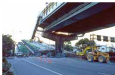
倒塌的阪神高速公路
