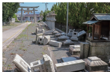
震災で倒れた灯篭
