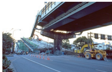
倒壊した阪神高速道路
