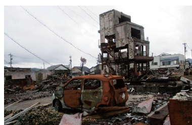
大規模火災があった朝市通り
