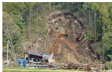
土砂崩れにより崩壊した民家
