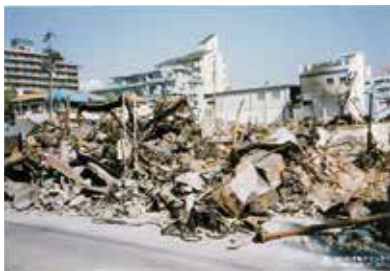
주택 피해와 번짐 화재 피해 모습 (한신 · 아와지 대지진)
