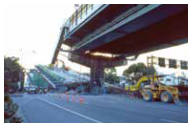
倒塌的阪神高速公路
