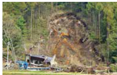
因土砂塌方毁坏的民家
