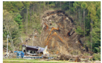
因土石塌方毀壞的一般住宅
