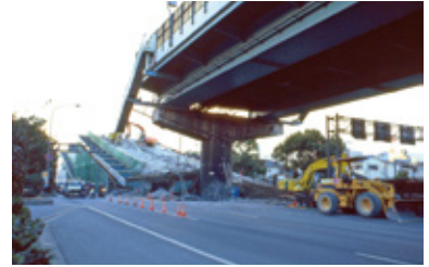
倒塌的阪神高速公路
