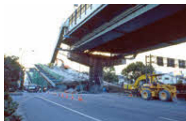
倒塌的阪神高速公路
