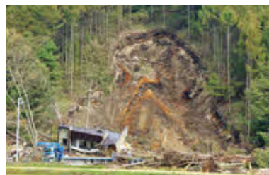
因土石塌方毀壞的一般住宅
