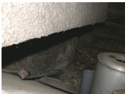
団地床下通風口が破損
