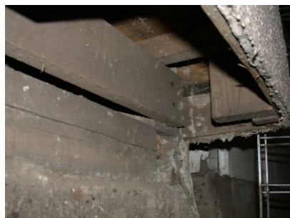
1 階台所出窓の下をしてみると、隙間だらけ
