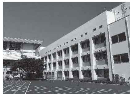
令和5年1月 プール棟完成
