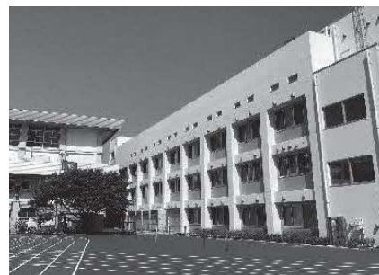
令和5年1月 プール棟完成
