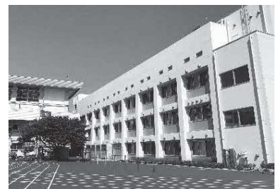
令和5年1月 プール棟完成
