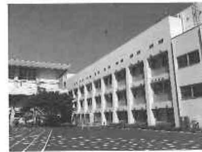
令和5年1月 プール棟完成
