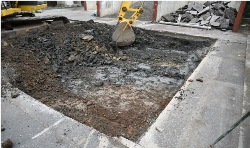
写真 1. 重機掘削風景
