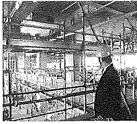
旧中小企業センターの工事現場を調査する高柳区議
