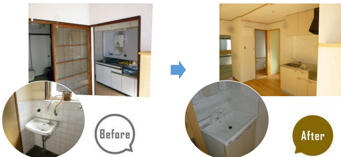
改修工事をしたセーフティネット住宅
