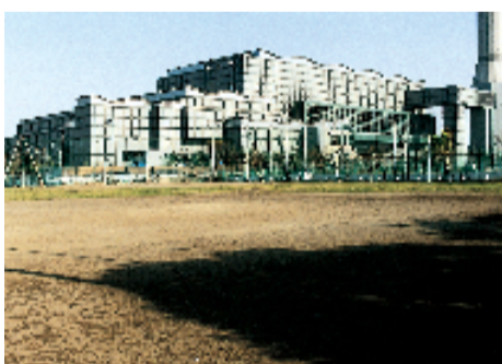
(仮称) スポーツ健康センター建設予定地
