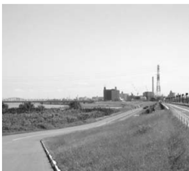
荒川河川敷の様子
