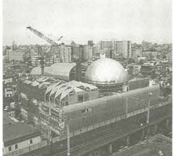
建設中の「すみだ生涯学習センター」
