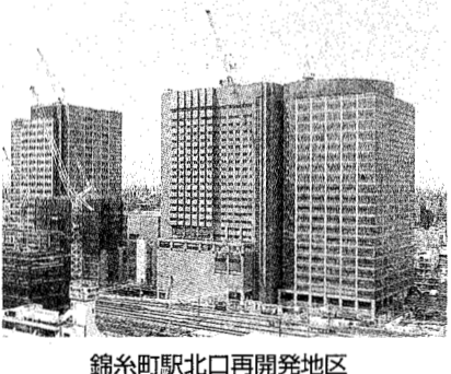
錦糸町駅北口再開発地区
