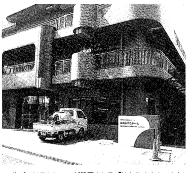
ヘルパーステーションが設置される「はなみずきホーム」
