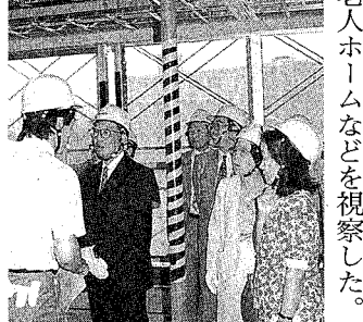
立花三丁目第二特別養護老人ホーム建設現場
