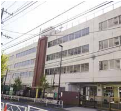
解体される吾孺立花中学校旧校舎
