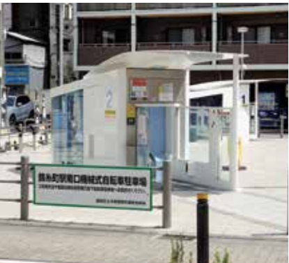
錦糸町駅南口機械式自転車駐車場
