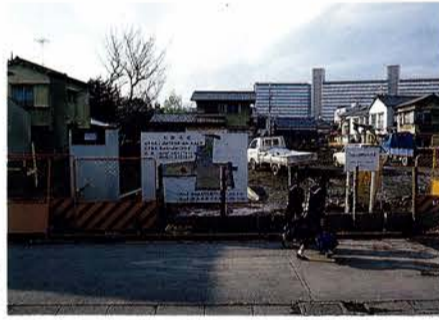
八広あずま公園建設工事
