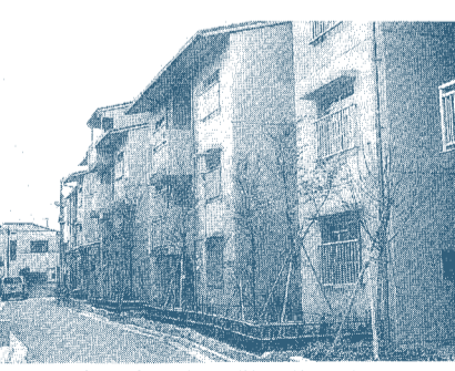
京島都営住宅
