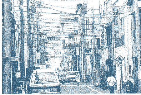
地中化が望まれる電線類
