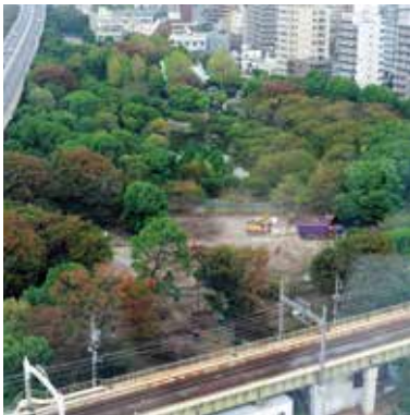
整備中の隅田公園
