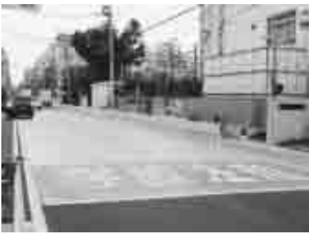
菊川小学校正門前の遮熱性舗装
