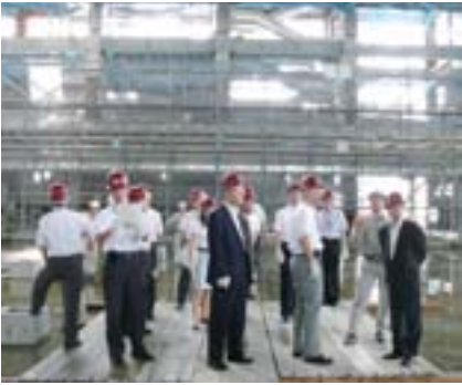
墨田区総合体育館建設地
